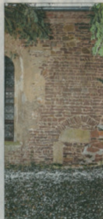
An der Nordwand sind Bögen der Vorgängerkirche zu erkennen.
