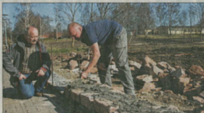
Die Mauer an der Nordseite entsteht neu.
