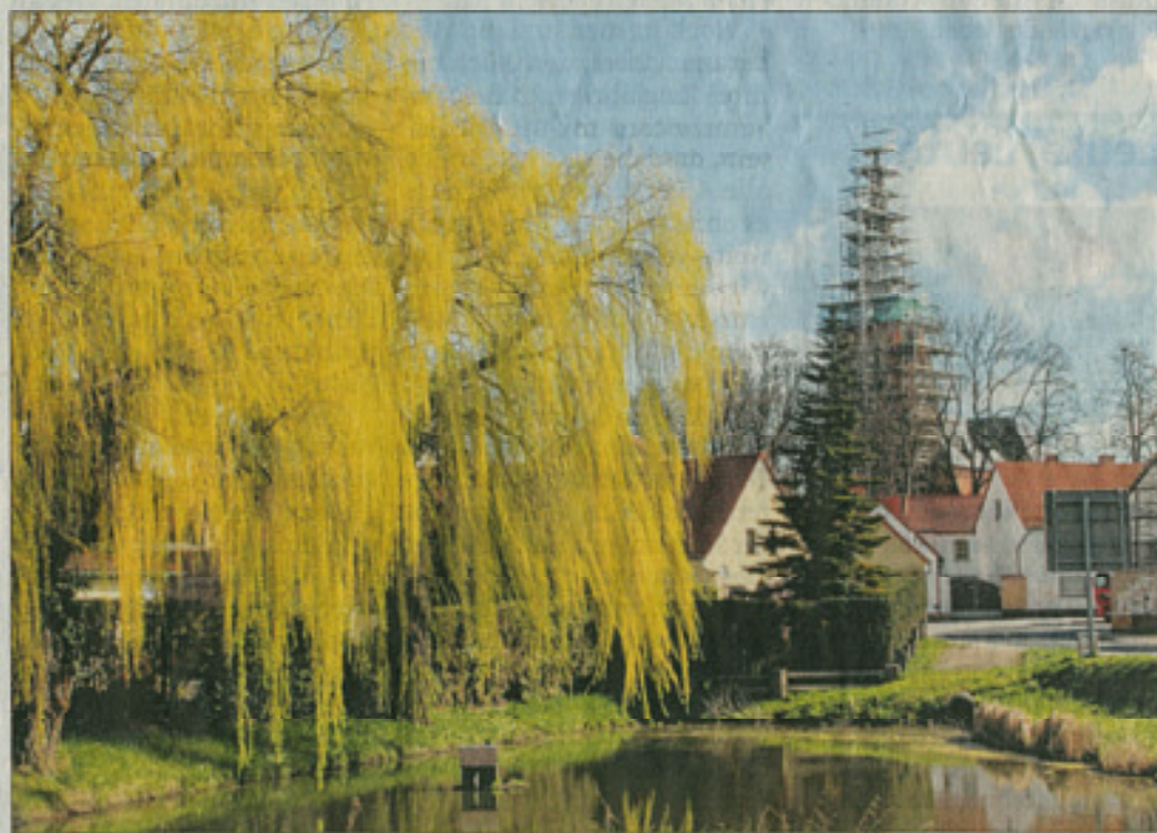
Das Ensemble von Teich und Kirche wurde sicher in den 1000 Jahren der Irxleber Geschichte schon häufig fotografiert, mit einem Gerüst am Kirchturm aber wohl eher selten. Foto: Constanze Arendt-Nowak
