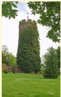
Der Landratsturm ist begehbar.
