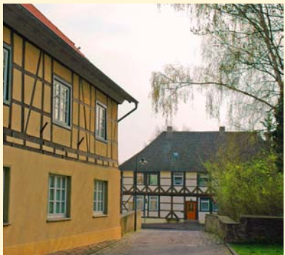
Der Eingangsbereich der Weferlinger Burgranlage mit dem Museum
